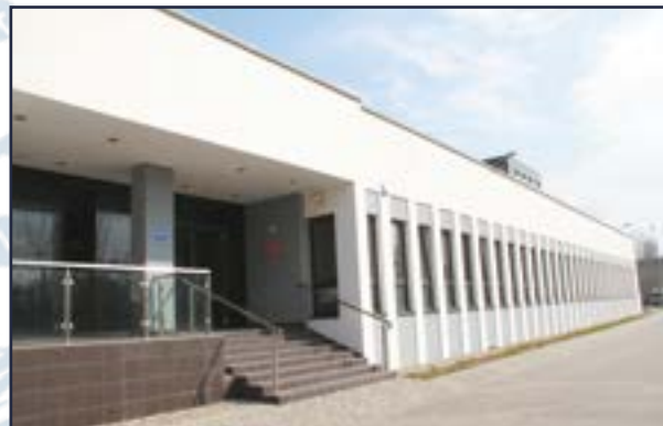
Siedziba Centrali AIPN w Warszawie, ul. Kłobucka 21
